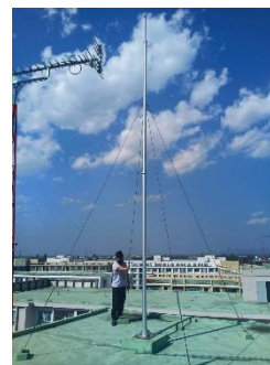
ระบบป้องกันฟ้าผ่าแบบเสาหล่อฟ้า
