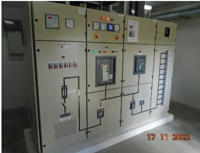
ภาพที่ 2-53 อุปกรณ์ตัดกระแสไฟฟ้าแบบอัตโนมัติ
